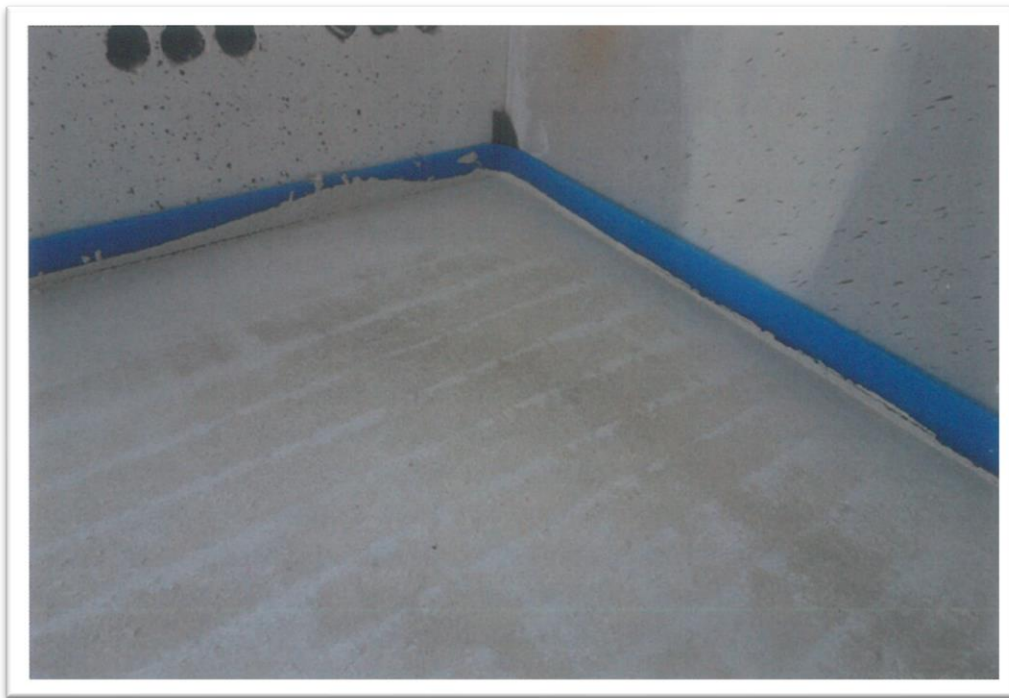
Abbildung 1 - Intensive "Sinterschicht" auf einem neu eingebauten beheizten Calciumsulfatestrich.
