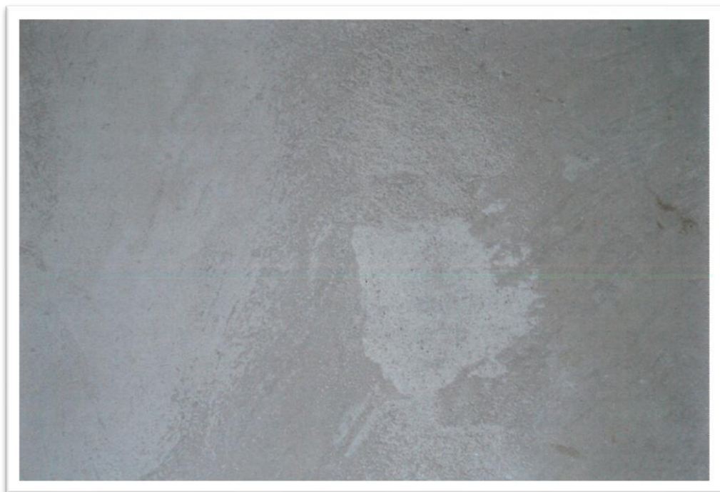
Abbildung 2 - Das Entfernen der "Sinterschicht" wurde mittels Drahtbürste geprüft.
